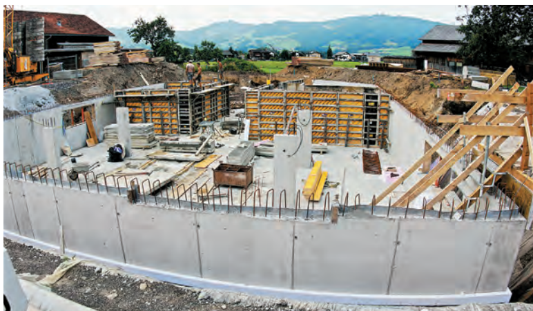
Baufortschritt des neuen Firmengebäude in Andelsbuch.
