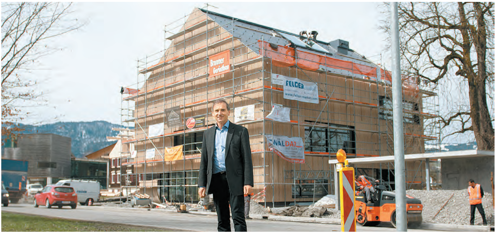
Obmann Walter RUF vor dem „fast“ fertiggestelltem Gebäude. Noch sind die Arbeiten an der Außenanlage in vollem Gange.
